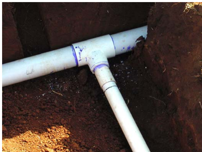
Figura 4.9- Assentamentos de tubos de PVC rígido em um campo de golfe. Observar a derivação lateral de menor diâmetro.
