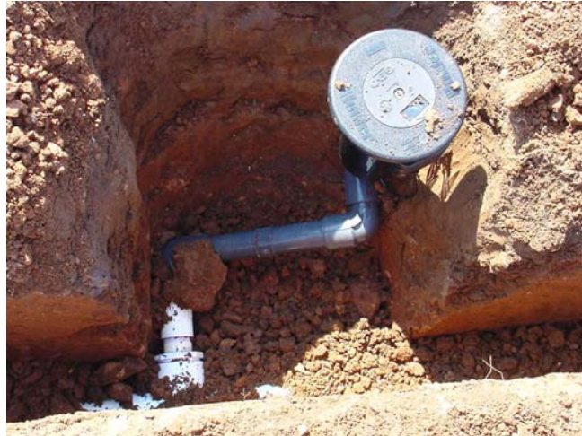
Figura 4.9- Assentamentos de tubos de PVC rígido em um campo de golfe. Observar a derivação lateral com um aspersor que se levanta automaticamente com a pressão da água.
