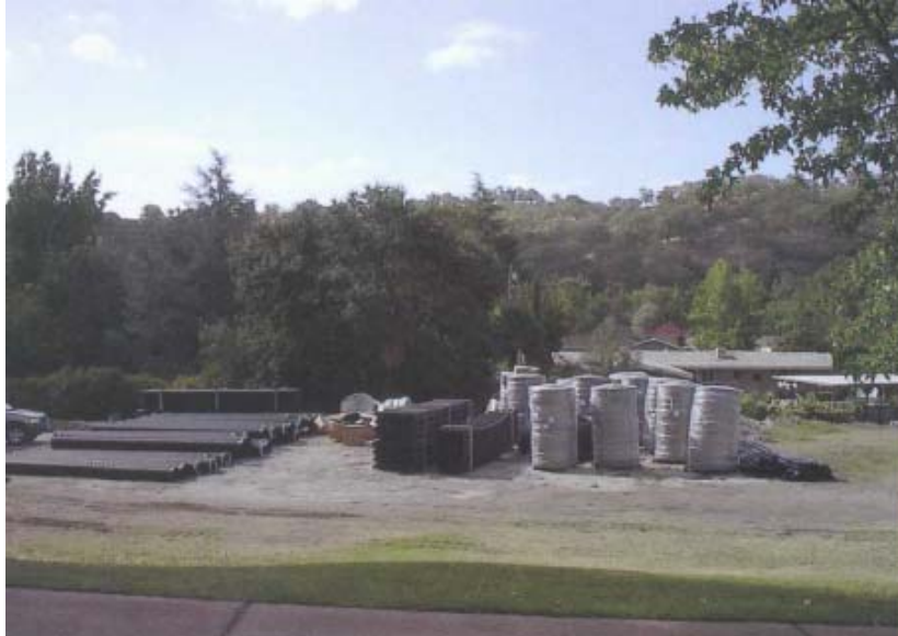
Figura 4.20- Matérias de drenagem estocados.
