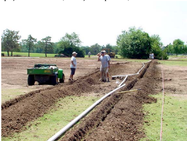
Figura 4.8- Assentamentos de tubos de PVC rígido em um campo de golfe.
