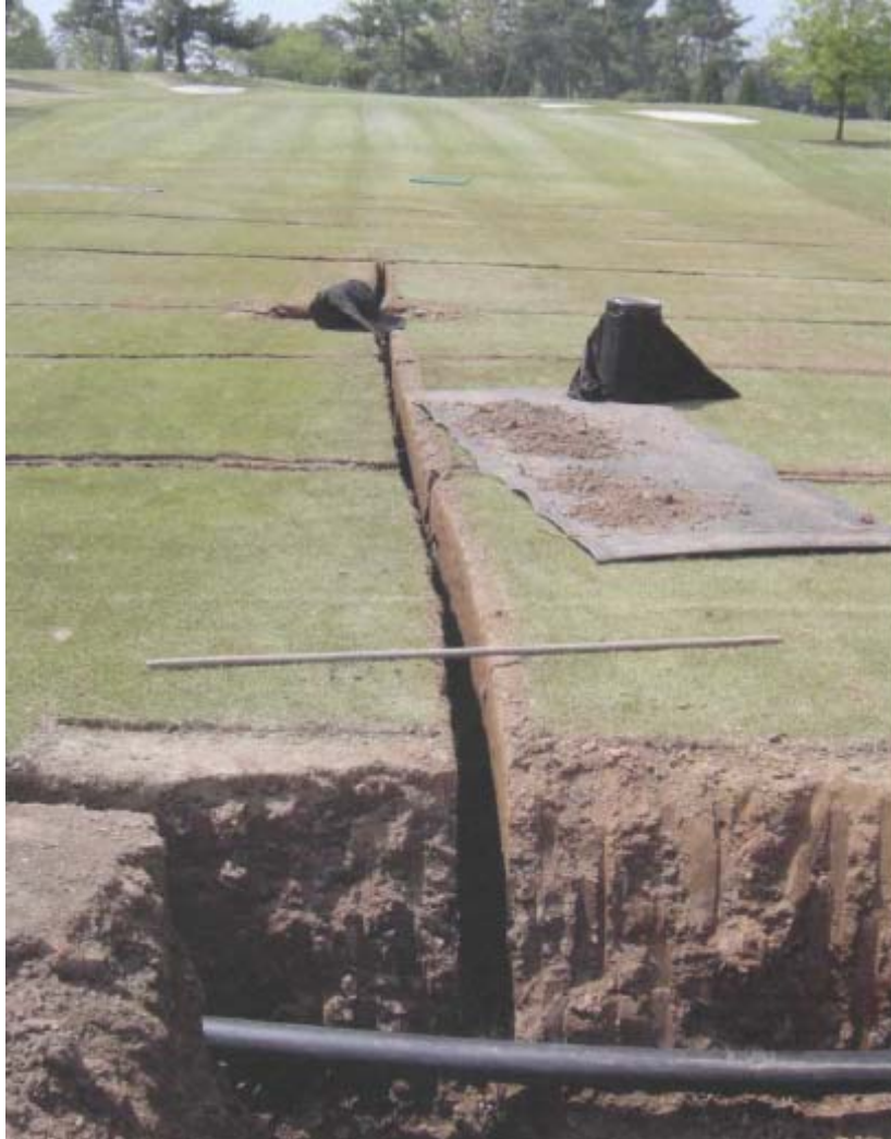
Figura 4.18- Obras de drenagem de um campo de golfe. Fonte: Green Section Record; Planning a golf course drainage project Patrick M; O'Brien
