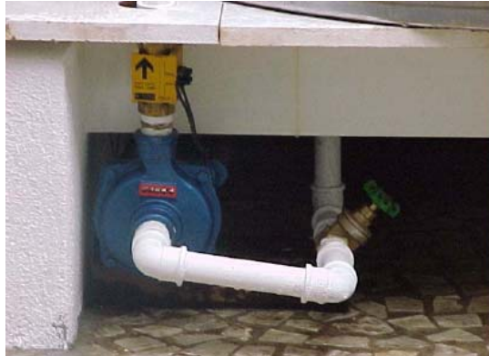
Figura 6.5- Bomba centrífuga
